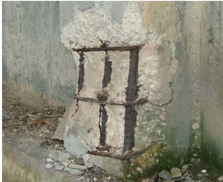
รูปที่ 2: รูปการกระเทาะออกของผิวคอนกรีต
