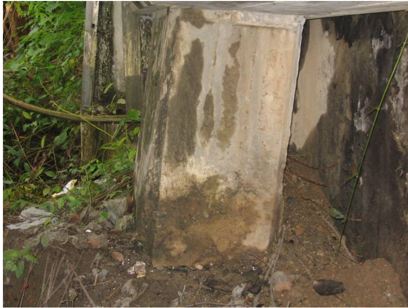
รูปที่ 4: รูปการบิดเบี้ยวหรือเคลื่อนตัวของโครงสร้าง
